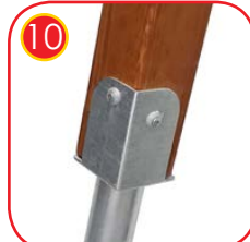
10 Holzpfähle , die mit feuerverzinkten Ankeren aus Stahl am Boden befestigt sind.
